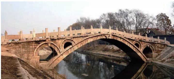
图1-10 河北赵县安济桥
