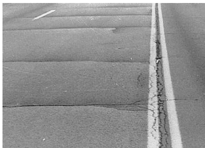
图 2-8 横向裂缝
