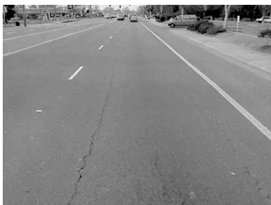
图 2-9 纵向裂缝
