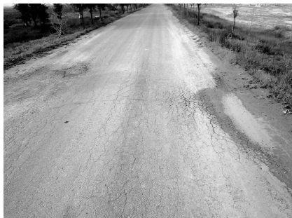
图 2-1 网裂和龟裂
