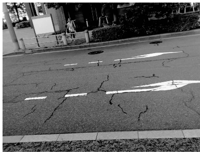
图 2-10 块状裂缝
