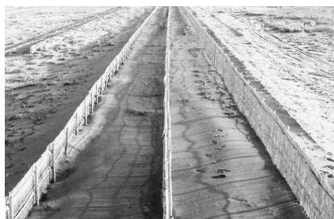
图 1-18 挡沙墙(堤)
