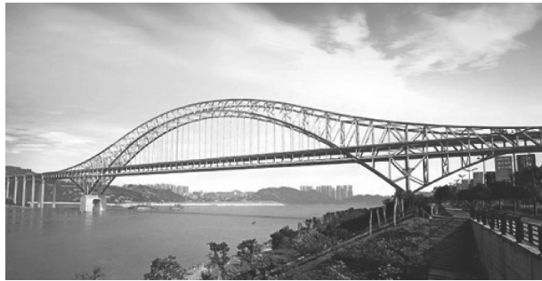
图 1-10 重庆朝天门大桥
