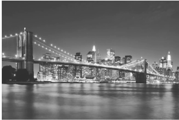
图 1-15 纽约布鲁克林悬索桥
