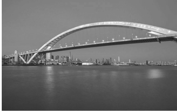
图 1-9 上海卢浦大桥
