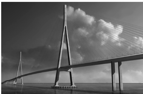
图 1-11 江苏苏通长江公路大桥
