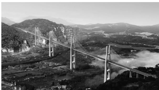
图 1-12 郴州赤石大桥
