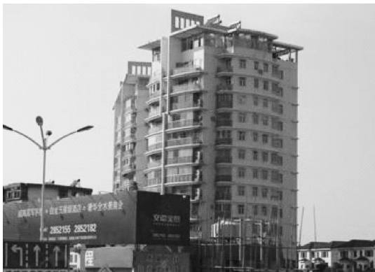
图 3-1 发生倾斜的高层建筑
